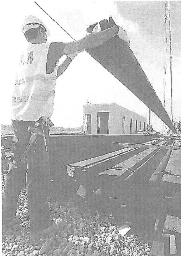
Un operario descarga una de las vías del metro, ayer en la zona de talleres y cocheras. ■ CARLOS MORET
